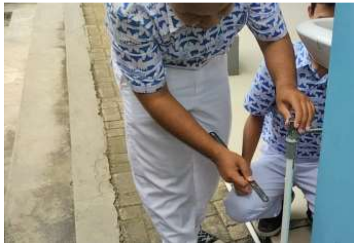
Gambar 4. Pemasangan Kran Otomatis
